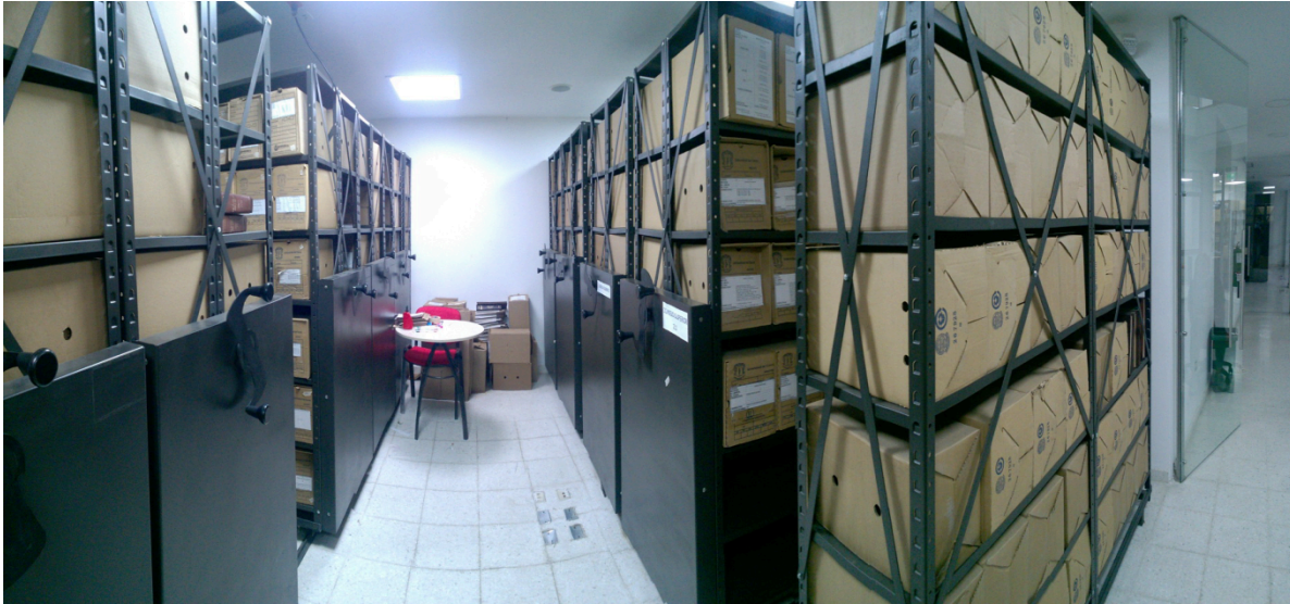
Figura No. 4, no cuenta con zonas de trabajo archivístico cómodo y seguro, las áreas destinadas para la organización de archivos se encuentran dentro de las de almacenamiento.
