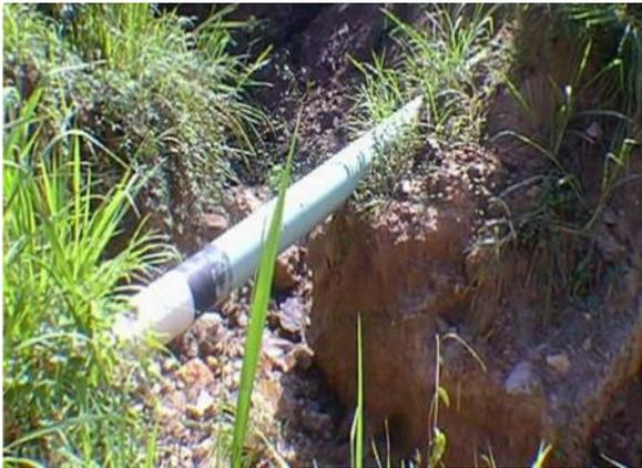
Figura 3. Tubo de gas socavado
