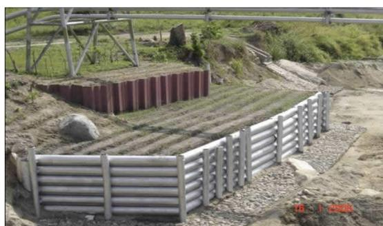
Figura 2. Margen de río y base de torre estabilizada
