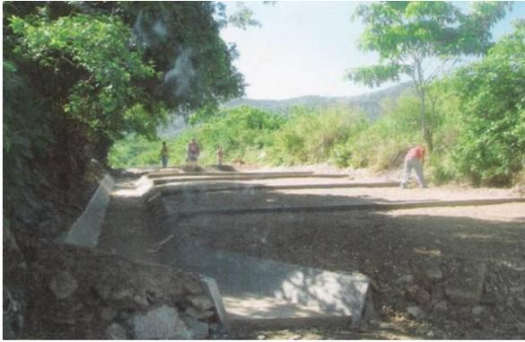
Figura 7. Plataforma estabilizada y tubo protegido
