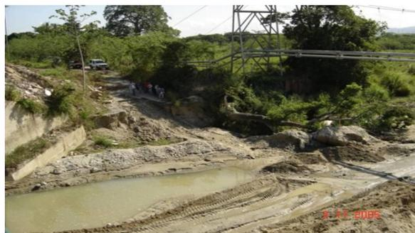
Figura 1. Erosión de banco de río y torre de suspensión socavada
