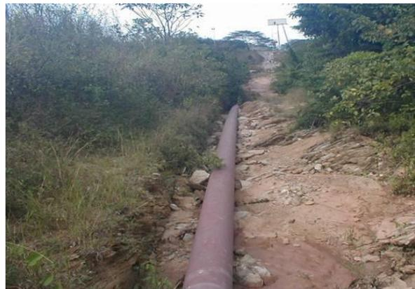
Figura 6. Afloramiento del tubo en plataforma
